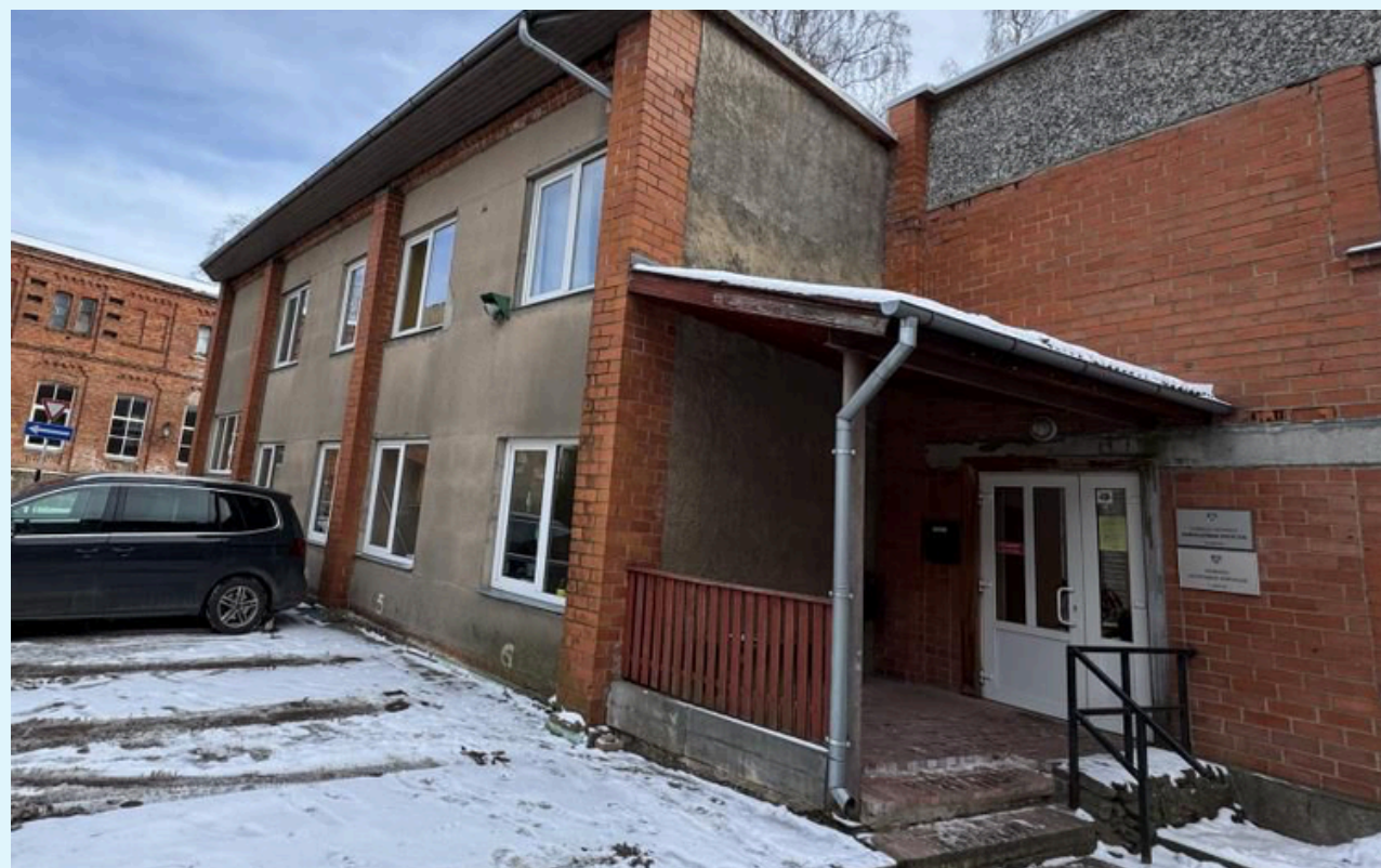
Ēkas Mūru ielā 17, Limbažos, energoefektivitātes paaugstināšana Kopējās izmaksas: 639 606 (fondu finansējums: 422 880, pašvald. 216 726)
