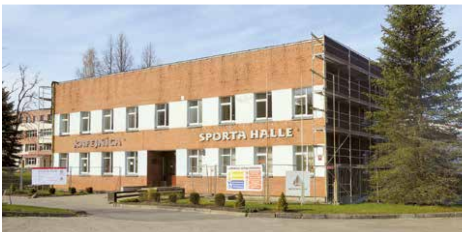
Limbažu un Salacgrīvas novadu sporta skolai renovēta fasāde. Būvdarbu ietvaros tiks veikta jumta seguma nomaiņa, bēniņu siltināšana, logu un durvju nomaiņa, kā arī tiks veikta ārsienas fasādes siltināšana, apdare u.c. darbi.
