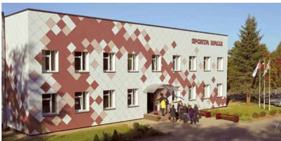
Limbažu un Salacgrīvas novadu sporta skolai renovēta fasāde. Būvdarbu ietvaros tiks veikta jumta seguma nomaiņa, bēniņu siltināšana, logu un durvju nomaiņa, kā arī tiks veikta ārsienas fasādes siltināšana, apdare u.c. darbi.
