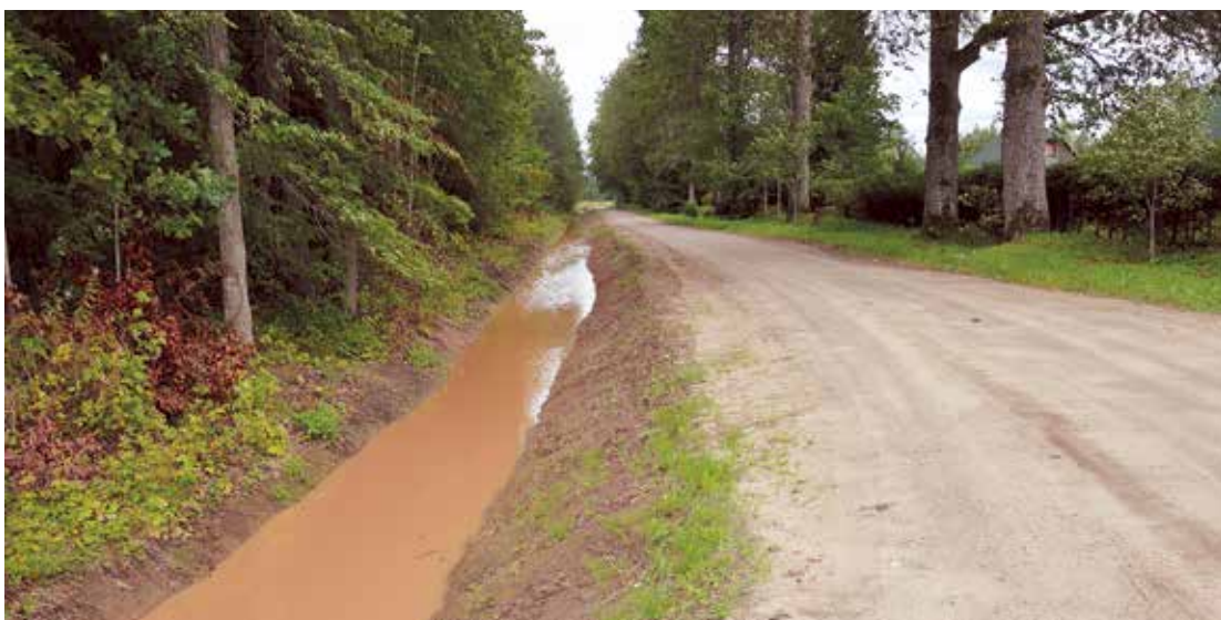
Ceļu stāvokļa uzlabošanai, sākot ar 2016. gadu aktīvi tiek strādāts pie sāngrāvju rakšanas un grants ceļu virsmas stāvokļa sakārtošanas.
