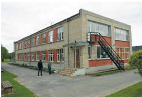
Renovēta Skultes pirmsskolas izglītības iestāde "Agupīte" – siltinātas ārsienas un cokols, mainīts jumta segums, ēkas gala sienām nomainīti logu bloki, uzstādīta saules kolektoru sistēma ar siltumsūkni u.c. darbi.
