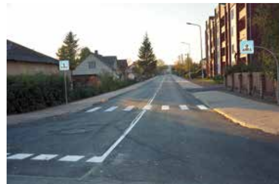
Limbažos pārbūvēta Valmieras iela. Pārbūves darbu ietvaros ielai uzklāts asfaltbetona segums, izbūvēts bruģēts gājēju celiņš abās ielas pusēs, ierīkots apgaismojums, kurš nodrošina ielas, krustojumu un gājēju pāreju izgaismošanu, kā arī uzlikti ātrumu ierobežojošie vaļņi.
