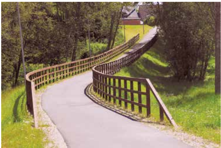
Izbūvēta tranzītiela no Rīgas ielas līdz Kr.Barona ielai Limbažos 2,031 km garumā, rekonstruēta tranzītiela no Rīgas ielas 67A līdz pilsētas robežai gandrīz 1,4 km garumā, izbūvēts apgaismots gājēju - velosipēdistu celiņš gandrīz 1,6 km garumā gar tranzītielu no Rīgas ielas 67A līdz pilsētas robežai.
