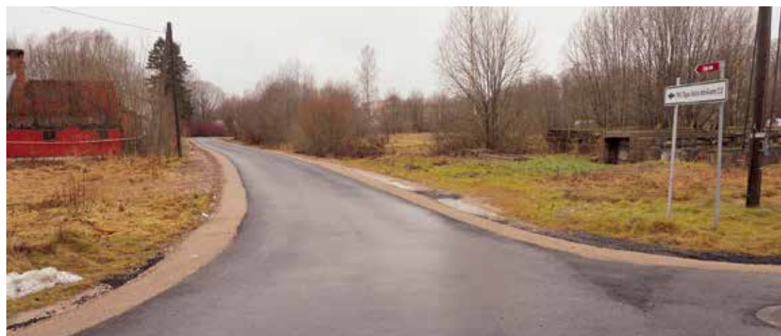
Zelļu ielai Limbažos uzklāts asfaltsegums. Profesionālās izglītības kompetences centrs "Rīgas Valsts tehnikums" no savas puses ieguldīja finansējumu tehnikuma administratīvās ēkas laukuma un tā pievadceļu asfaltēšanai.
