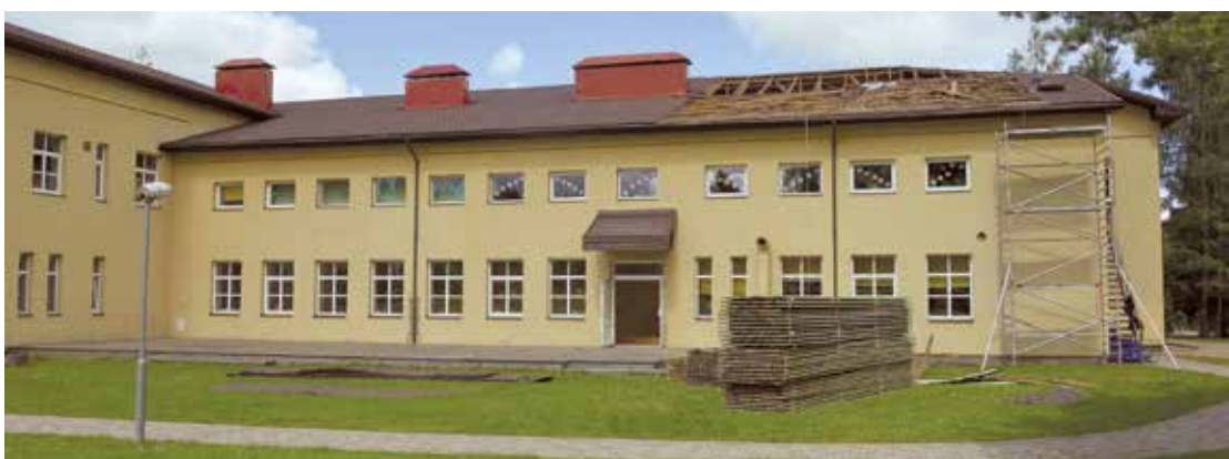
Lādeзера pamatskolai veikta jumta seguma nomaiņa un telpu remontdarbi.
