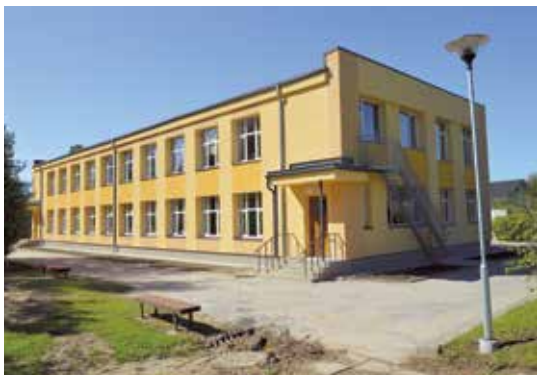
Renovēta Skultes pirmsskolas izglītības iestāde "Agupīte" – siltinātas ārsienas un cokols, mainīts jumta segums, ēkas gala sienām nomainīti logu bloki, uzstādīta saules kolektoru sistēma ar siltumsūkni u.c. darbi.
