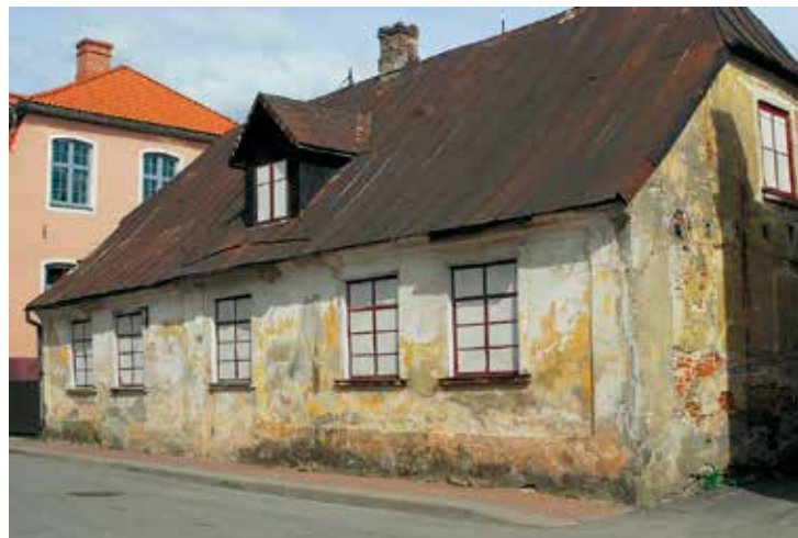
Pārbūvējot ēku Burtņieku ielā 2, Limbažos tiks izveidots uzņēmējdarbības un sociālās uzņēmējdarbības atbalsta centrs.
