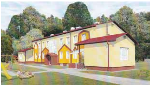
Šovasar uzsāksies Viļķenes pirmsskolas izglītības iestādes renovācijas darbi. Renovācijas ietvaros plānots uzlabot ēkas energoefektivitāti, veikt iekštelpu remontu un sakārtot ēkas iekšpagalmu, atjaunojot celiņu uz pirmsskolas izglītības iestādi. Ēkai tiks siltinātas ārsienas, nomainīti logi un durvis, uzstādīts jauns granulu katls ar automātisku granulu padevi, izbūvēta apkures sistēma, laboti un nostiprināti pamati, sakārtota ūdensapgāde un kanalizācija, izbūvēta jauna lietus ūdens kanalizācijas un drenāžas sistēma, kā arī tiks veikti citi darbi.
