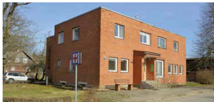
Viļķenē tiks pārbūvēta veselības aprūpes ēka, nomainot jumtu, renovējot fasādi un izremontējot 1. stāva telpas.
