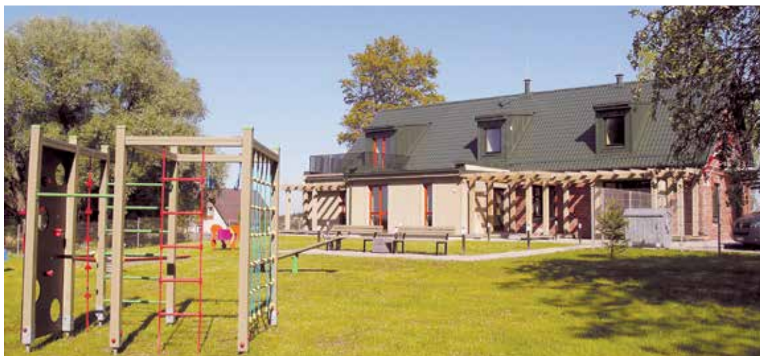
Katvaru pagasta Pociemā pabeigta Vecās pagastmājas rekonstrukcija. Rekonstruētajās telpās izvietota pirmsskolas izglītības iestāde, ar jaunām mēbelēm un rotaļlietām, bet līdzās iekārtots jauns bērnu rotaļu laukums.
