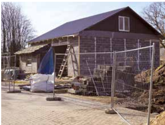
Notiek Ozolaines pirmsskolas izglītības iestādes katlu mājas būvniecība.
