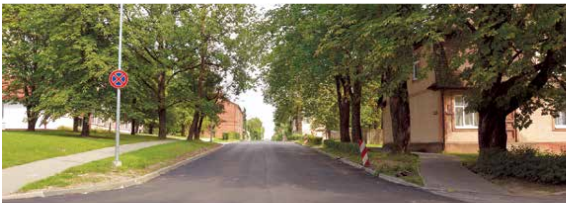
Jaunās ielas rekonstrukcija tika uzsākta 2014.gadā, rekonstruējot posmu no Jūras ielas līdz Parka ielai, bet 2015. gadā tā turpinājās, rekonstruējot posmu no Rīgas ielas līdz Stacijas ielai. Rekonstrukcijas ietvaros abiem posmiem veikta asfaltbetona seguma atjaunošana, ietvju rekonstrukcija un aku renovācijas darbi. Savukārt 2016.gadā tika pabeigti Jaunās ielas seguma atjaunošanas darbi posmā no Parka ielas līdz Rīgas ielai.
