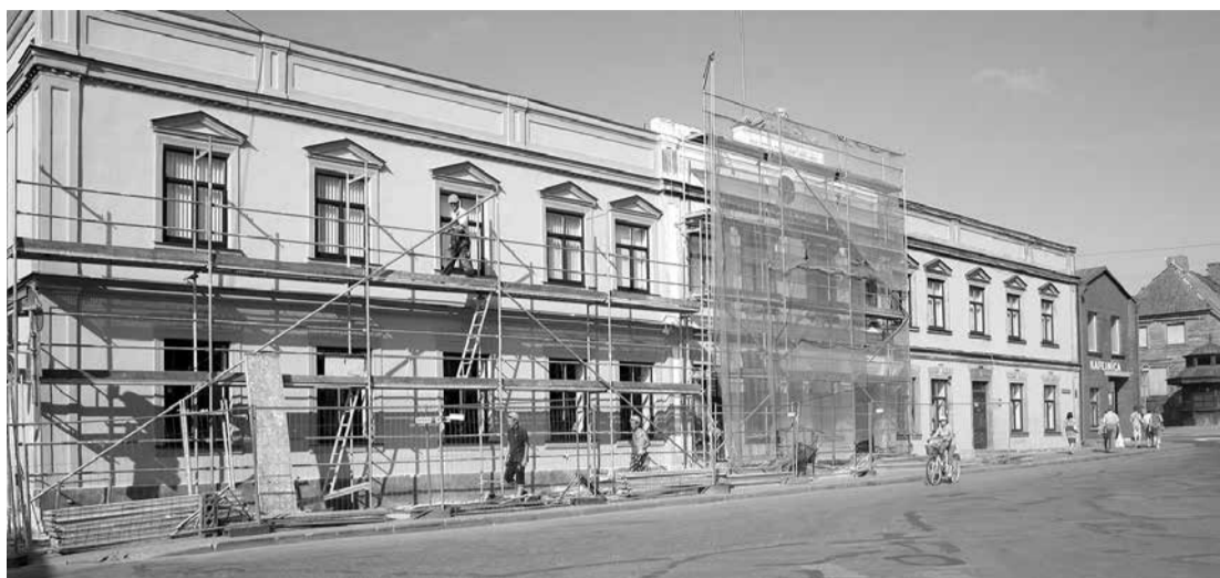
Ēkas Baumaņu Kārļa laukumā 1 fasādes rekonstrukcija.
